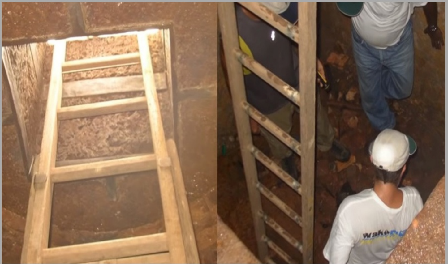
SISTEMA DE TÚNEL NO REAL FORTE PRINCIPE DA BEIRA EM COSTA MARQUES
